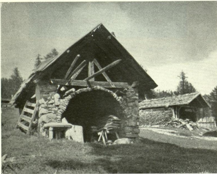
Abb. 9. Backofen beim Wirtshaus in Flaas (westlich Bozen).
